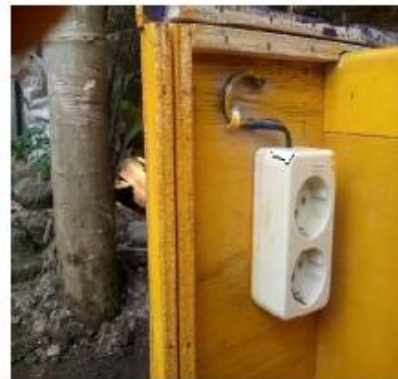
Gambar 8. Pembuatan Pondasi Sumber Listrik
