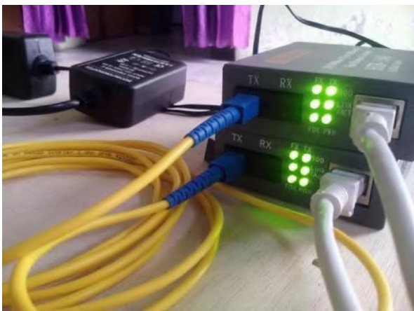
Gambar 11. Pemasangan konverter kabel fiber optic
