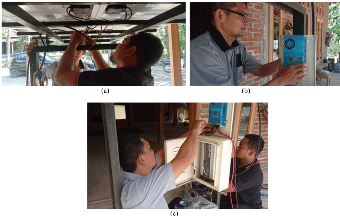
**Gambar 6.** (a) Perakitan modul solar cell, (b) Perakitan modul Scc, (c) perakitan modul Inverter
