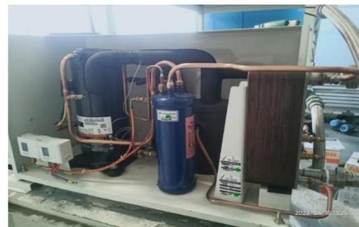
Gambar 3. Unit refrigerasi dengan sistem *water loop* yang telah dirakit
