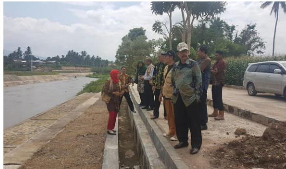
Gambar 4. Pembangunan jalan dan fasilitas rekreasi bagi masyarakat sekitar.
