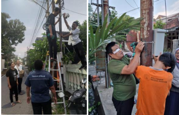
Gambar 6. Pemasangan Perangkat CCTV
